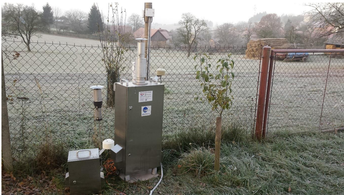
Obr. 7 Vybudovaná monitorovací stanice v Stříteži
