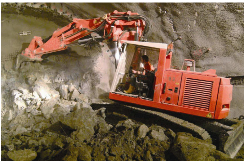
Obrázek 5: Hydraulické rypadlo při práci na čelbě
