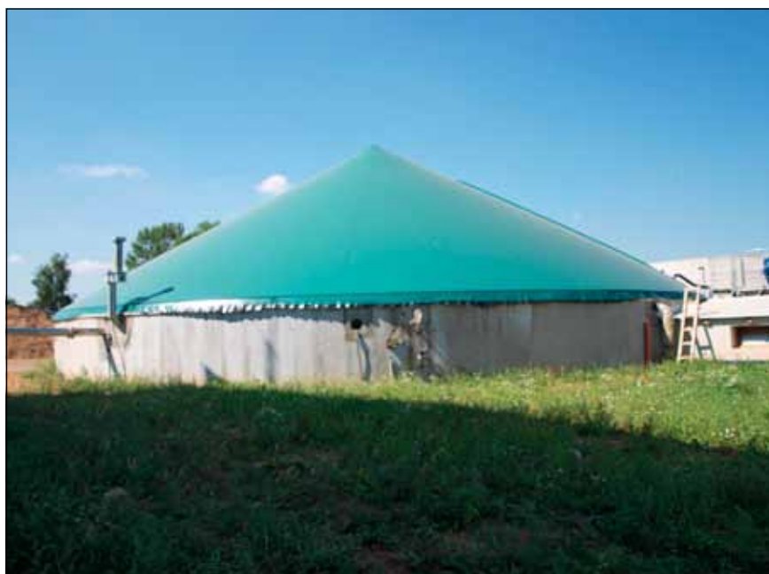
Bioplynové stanice pomáhají energetické soběstačnosti v obcích.
