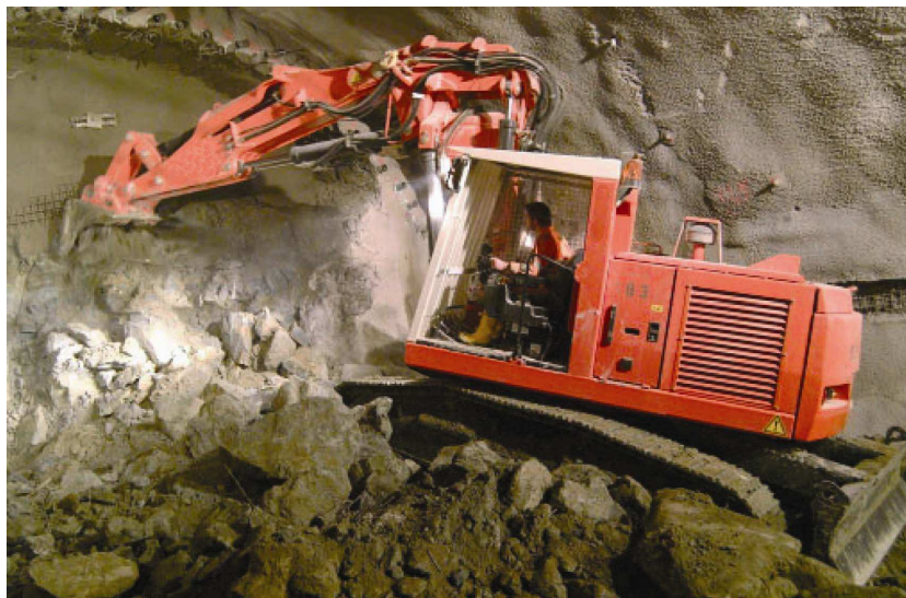
Obrázek 5: Hydraulické rypadlo při práci na čelbě
