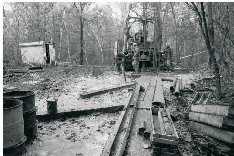
Vysekaný manipulační prostor 150 metrového vrtu.
