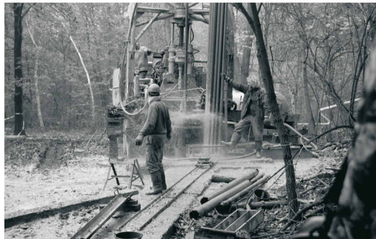
Stříkající výplach z vrtu.
