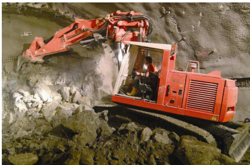
Obrázek 5: Hydraulické rypadlo při práci na čelbě
