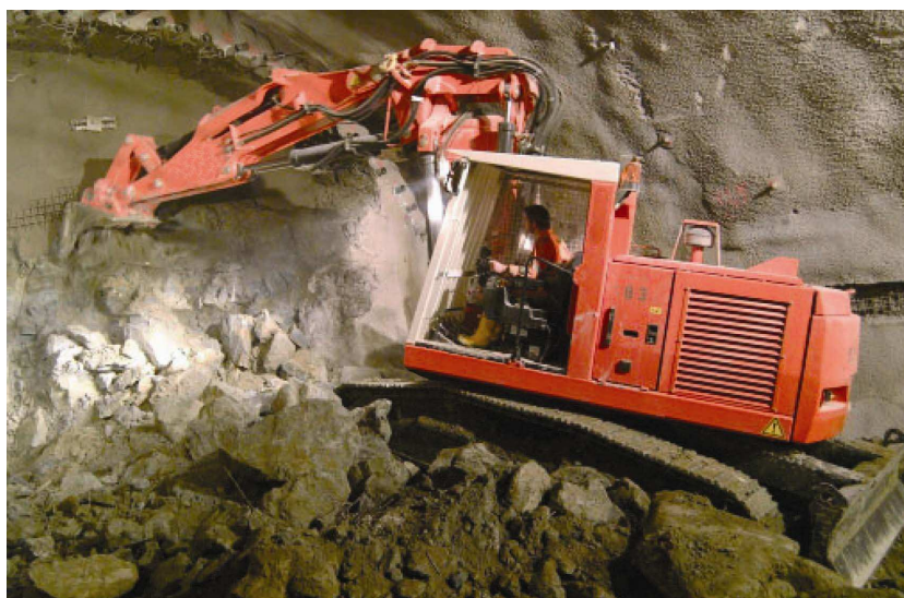
Obrázek 5: Hydraulické rypadlo při práci na čelbě
