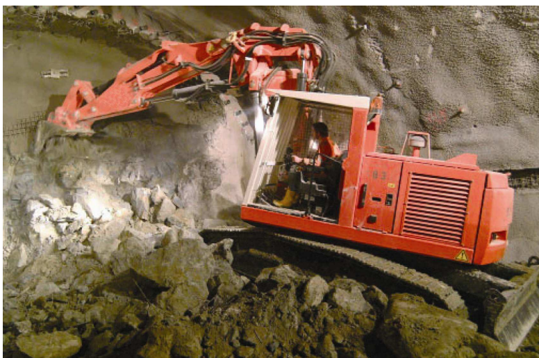
Obrázek 5: Hydraulické rypadlo při práci na čelbě
