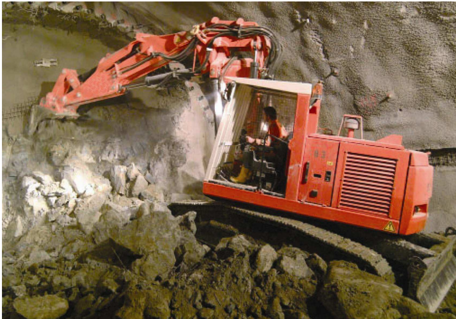
Obrázek 5: Hydraulické rypadlo při práci na čelbě
