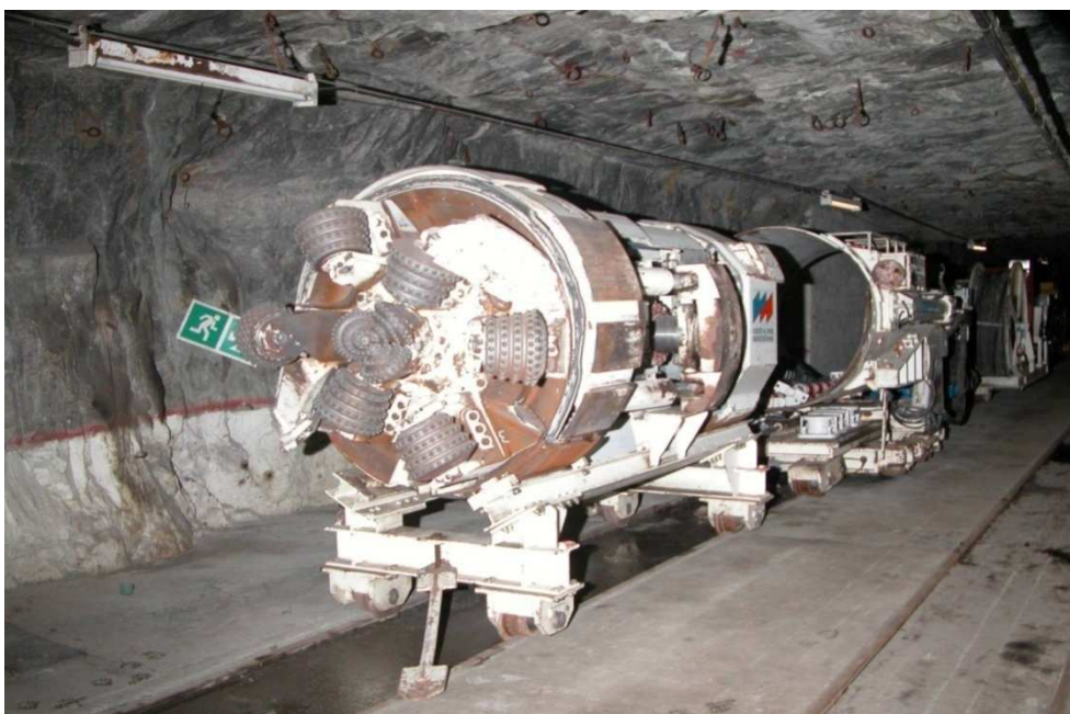
Obrázek 32: Velkoprofilové vrtací zařízení v remíze. Ilustrační foto.
