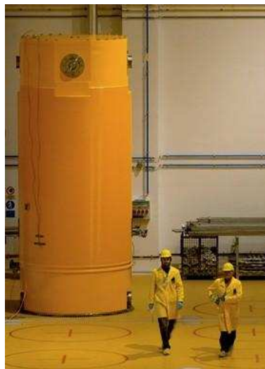
CASTOR - 5,5 m vysoký kontejner pro uskladnění vyhořelého jaderného paliva. Váha kontejneru při naplnění: 116 tun, uvnitř je asi 20 tun vyhořelého paliva.
